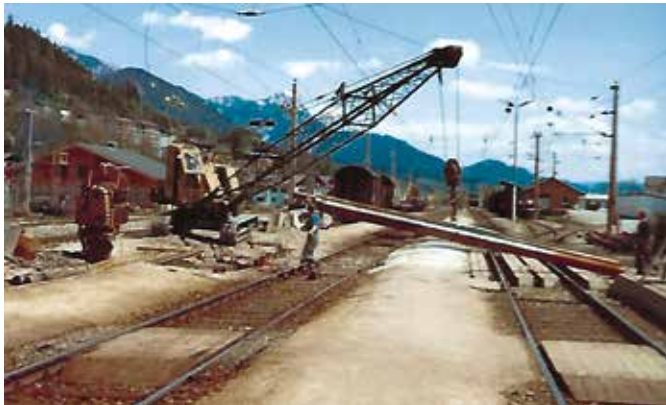
Impressionen von den vielfältigen Bau- und Modernisierungsarbeiten am Schladminger Bahnhof zwischen 1975 und 1980.
